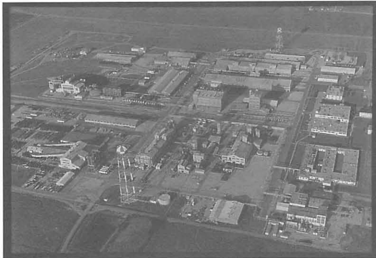
Le centre de production de combustible d'alimentation (du site de Fernald). Les silos ne sont pas visibles, mais sont situés hors du bas du coin de gauche de cette photo.
