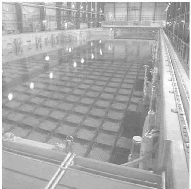
*Piscine d'entreposage du combustible usé, usine de retraitement de COGEMA-La Hague. Les assemblages de combustible irradié sont placés dans des paniers et entreposés sous l'eau pour au moins deux ans avant d'être retraités.*
