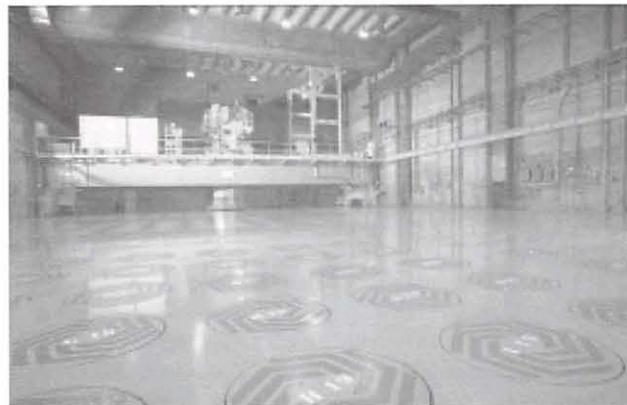
*Hall d'entreposage de l'installation de vitrification, usine de retraitement de La Hague, France. Ce bâtiment sert à entreposer les déchets hautement radioactifs produits à la suite du retraitement de combustibles nucléaires usés, une fois vitrifiés et conditionnés dans des fûts d'acier inoxydable. Les fûts de déchets ne sont pas visibles sur cette photo parce qu'ils sont entreposés à sec en sous-sol dans des puits refroidis par air.*
