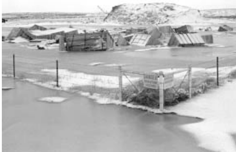
Des cartons et des fûts remplis de déchets radioactifs de faible activité sont partis à la dérive lors de l'inondation de la tristement célèbre fosse 9 à la suite d'importantes fontes de neige et de pluies printanières en 1969. Des inondations dans cette zone se sont aussi produites en 1962 et 1982. Depuis des digues et des fossés de dérivation de drainage ont été construits, mais cette zone est encore de temps en temps engorgée.
